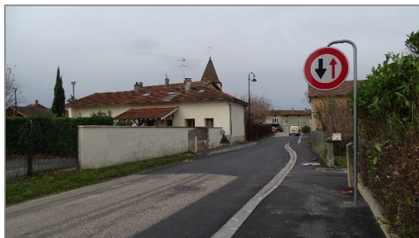
Aménagements de mise en sécurité à l'Est du centre bourg (automne 2025) (alternat de circulation, trottoirs, traversées sécurisées, ...)
