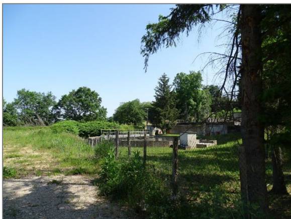
Station d'épuration de Saint-André-sur-Vieux-Jonc
