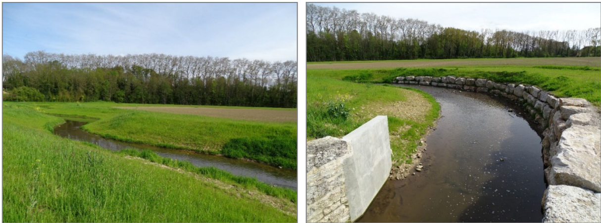
Reméandrage de la Veyle au niveau du seuil de la Frétaz - campagne de terrain d'avril 2023
