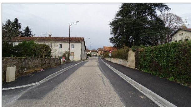
Aménagements de mise en sécurité à l'Est du centre bourg (automne 2025) (alternat de circulation, trottoirs, traversées sécurisées, ...)
