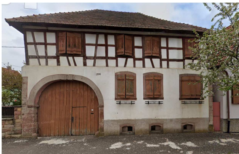
Bâti traditionnel marquant la rue Principale de Meistratzheim
