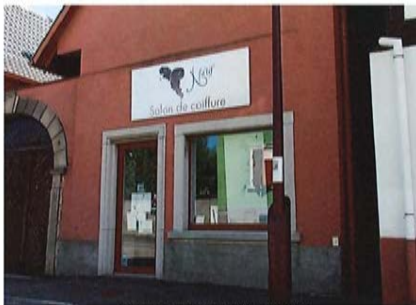
Une enseigne parallèle au mur
