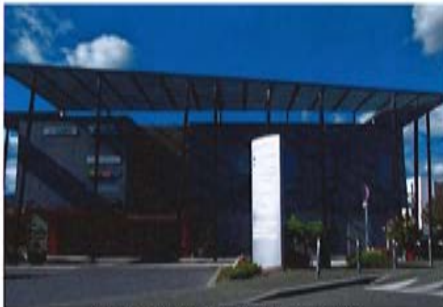
Enseigne non conforme au RLP
