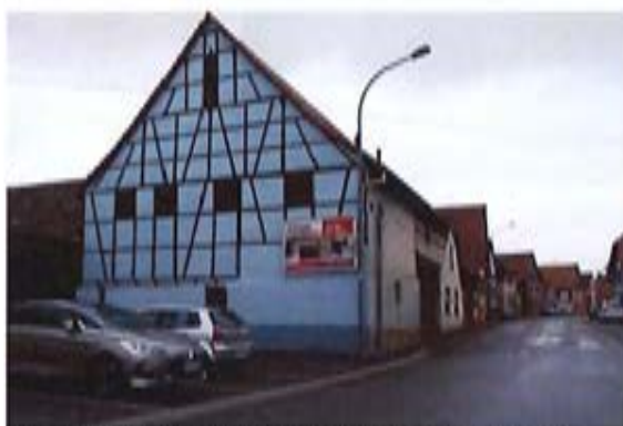
Altération de l'architecture traditionnelle
