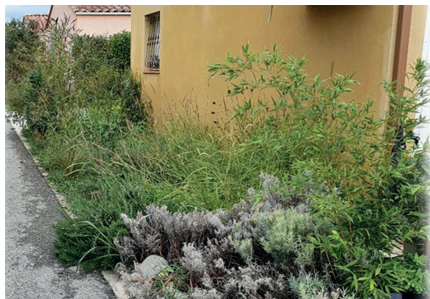
Aménagement paysager au pied des façades des constructions pour infiltrer les eaux de voirie et de toiture (source : lotissement des Vignes de Muscat - Volx 04)
