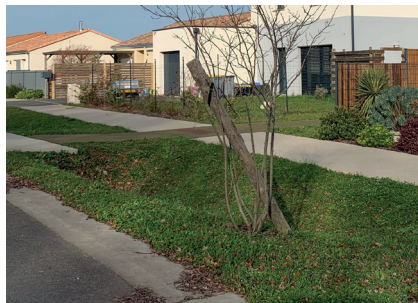
Noue végétalisée avec infiltration gravitaire (source : Cittanova Saint-Père-en-Retz 06.12.2023)
