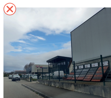
Abords dégradés - Parc d'activités du Stade (Bernardswiller)
