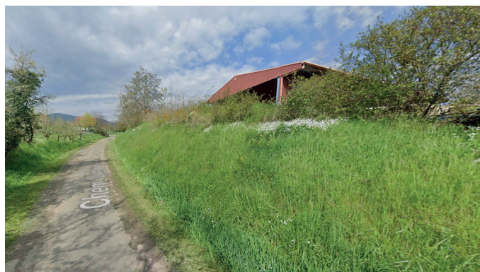
A Bernardswiller, la végétation marquée par le talus planté et les haies minimise l'impact visuel du bâtiment depuis le chemin. (image Google)
