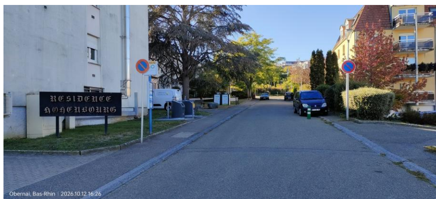
Figure 3 — Rue du Foyer, vue vers l'ouest (notre photographie du 12/10/2026) : une chaussée étroite entre les immeubles collectifs, appelée à recevoir une partie du trafic descendant de La Haul.
