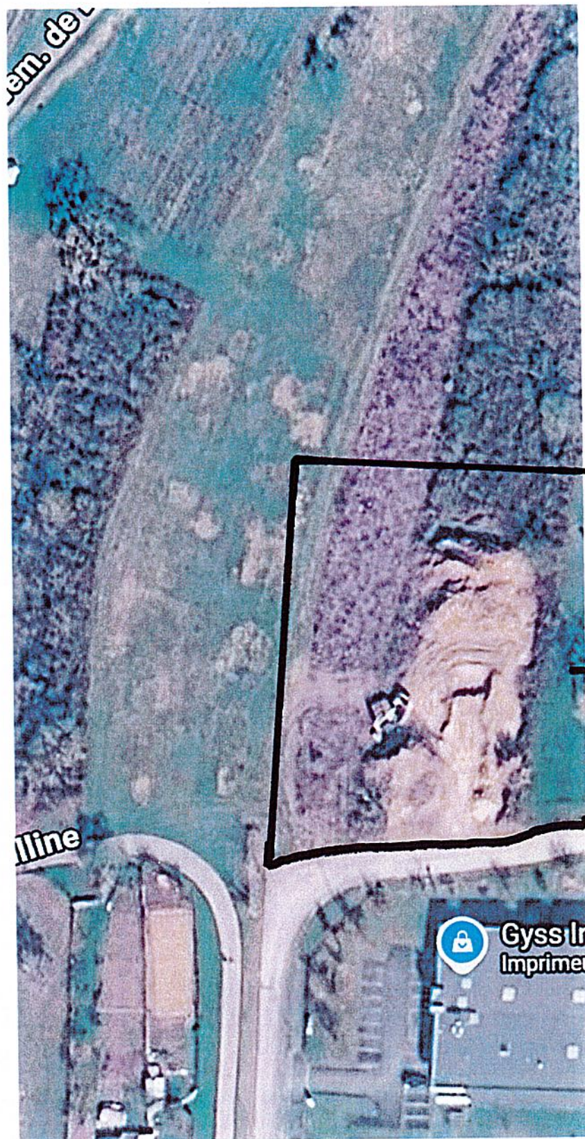
Vue aérienne du secteur d'extension de la ZA du Thal
