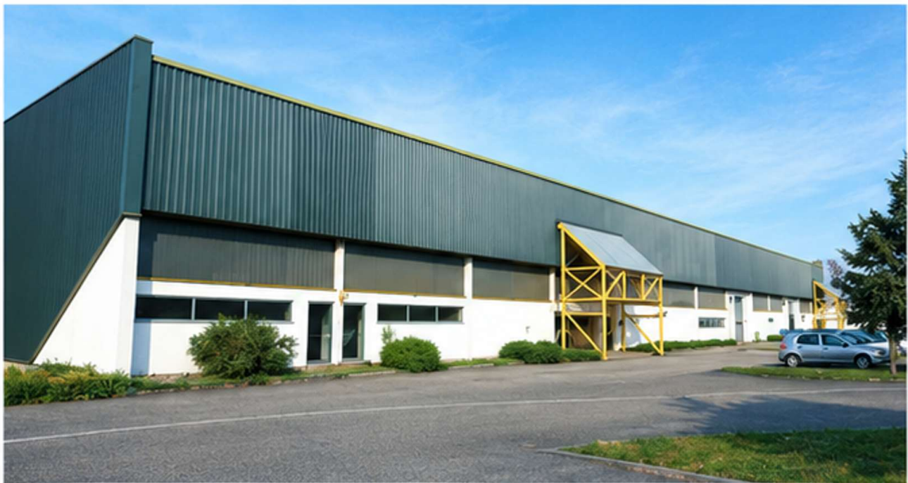
Vue d'ensemble du bâtiment depuis l'entrée sur le site
