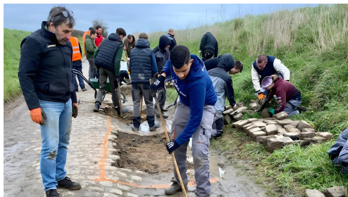
Travaux d'entretien par le lycée horticole de Raismes, encadré par les Amis de Paris-Roubaix
