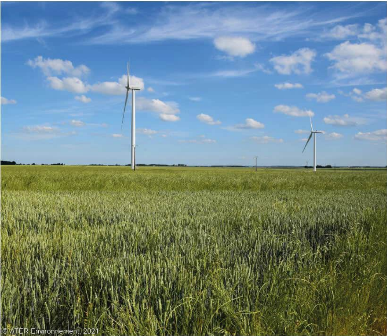
Figure 49 : Parc éolien de Marcheville depuis la D30.2 (source : ATER Environnement, 2023)
