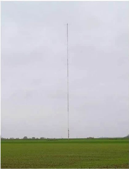
Figure 206 : Photographie du mât installé sur le site (source : Orfea, 2023)
