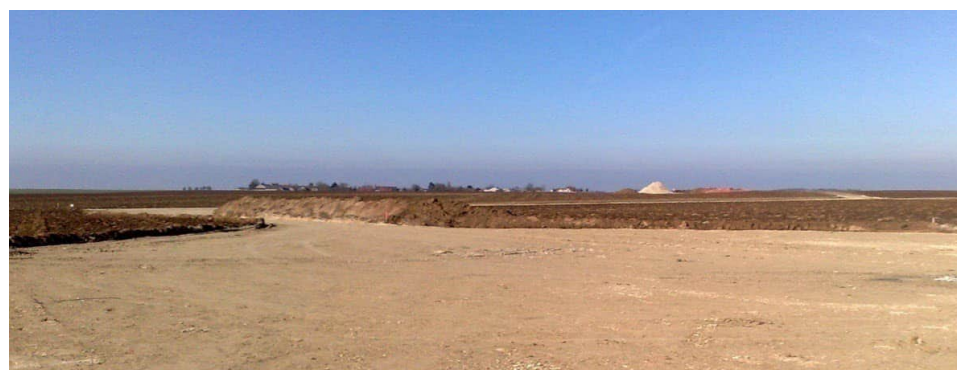
Figure 247 : Exemple d'aire de montage, grave compactée sur géotextile
