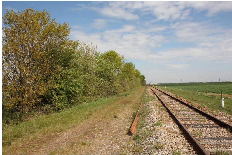
Figure 148 : Linéaire arbustif au long de la voie ferrée (source : Institut d'Ecologie Appliquée, 2025)
