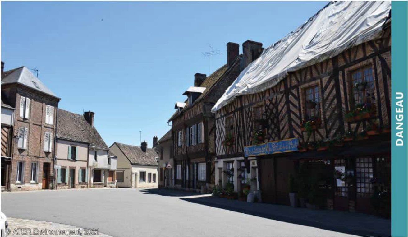
Figure 96 : Vue sur le centre de Bonneval (source : ATER Environnement, 2023)
