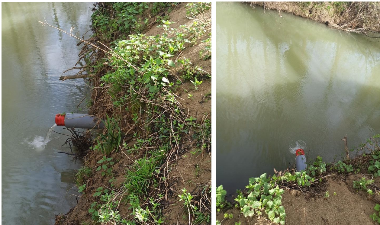
Figure 13 : Photographies du drain n°1
