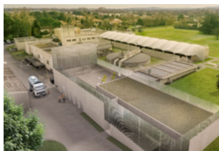
Tournefeuille (31) 2 000 m³/h Eau de rivière Mise en route 2025
