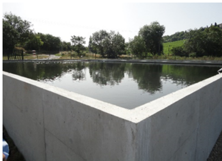
LIT EN REMPLISSAGE
