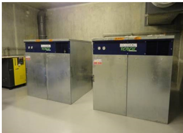
EXEMPLE SURPRESSEURS AIR DE LAVAGE
