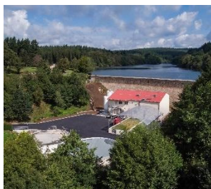
Le Pas des Bêtes (81) 380 m³/h Eau de barrage Mise en route 2013
