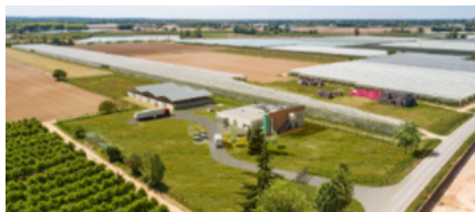
Nègrepelisse (82) 350 m³/h Eau de rivière Mise en route 2024
