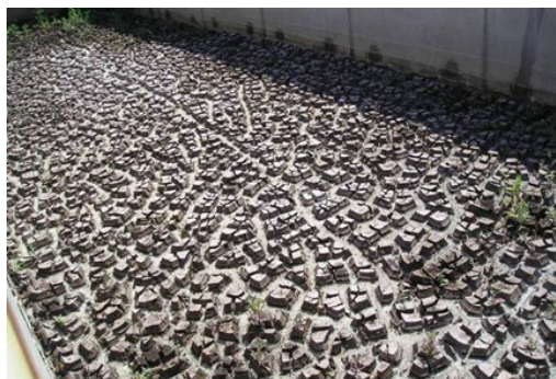
EXEMPLE DE BOUES SÉCHÉES SUR LITS DE SÉCHAGE
