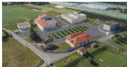
Montauban (82) 1 200 m³/h et 600 m³/h Eau de rivière Mise en route 2024
