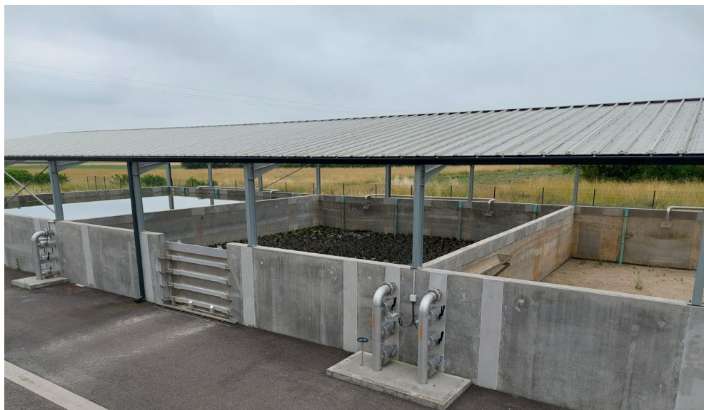
3 LITS DE SÉCHAGE (couverts) -- USINE DE BAS QUERCY (82)
