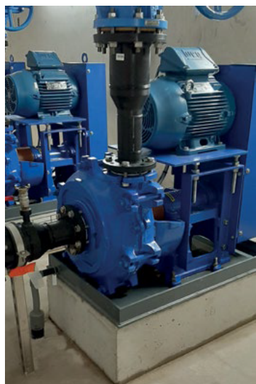
EXEMPLE DE POMPE DE RECIRCULATION
