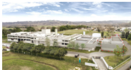
Clairfont (31) 4 640 m³/h Eau de rivière Mise en route 2025
