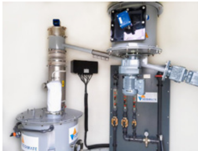
Système de mouillage et injection du charbon
