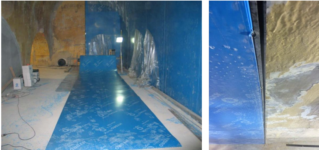
Figure 15 : Mise en œuvre des plaques PEHD
