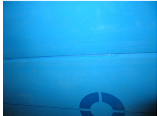
Figure 16 : Soudure des plaques
