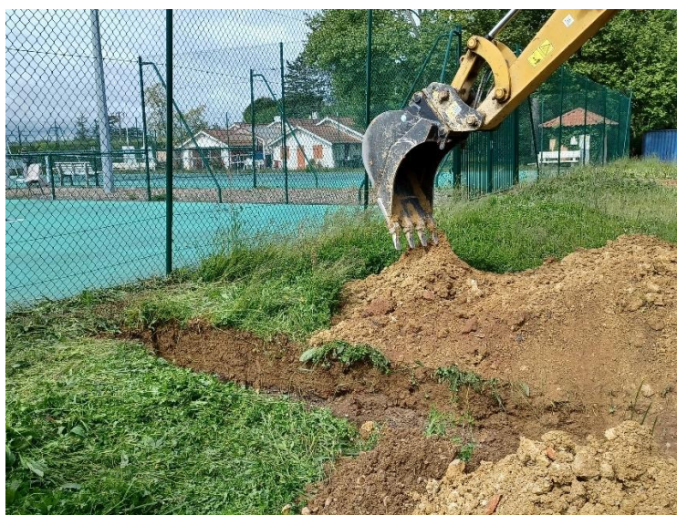
Figure 9 : Terrassement réalisé petite cuve
