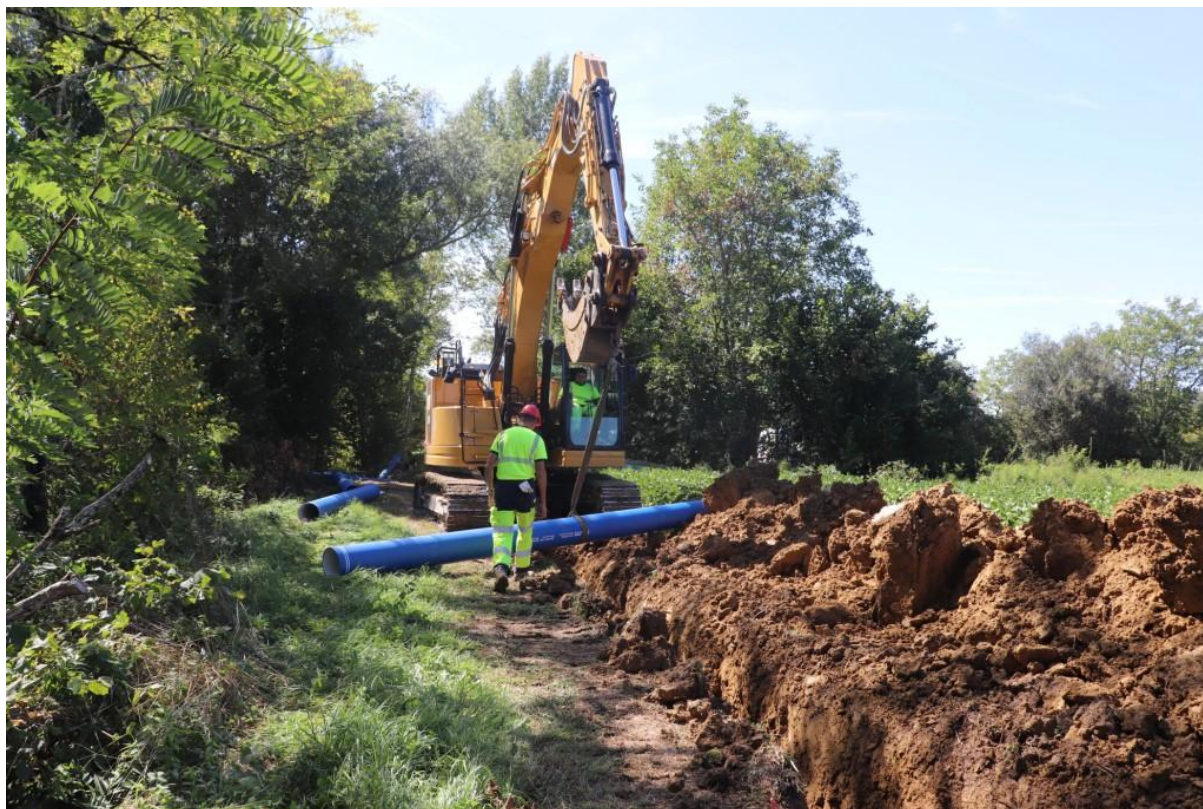
Figure 30 : Illustration de creusement d'une tranchée et de la mise en place d'une canalisations sur un projet similaire © ETEN environnement
