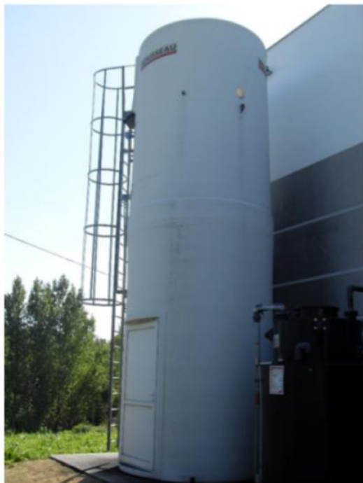
Figure 44 : Exemple de Silo Jupe et d'hydroéjecteur pour le dosage du charbon
