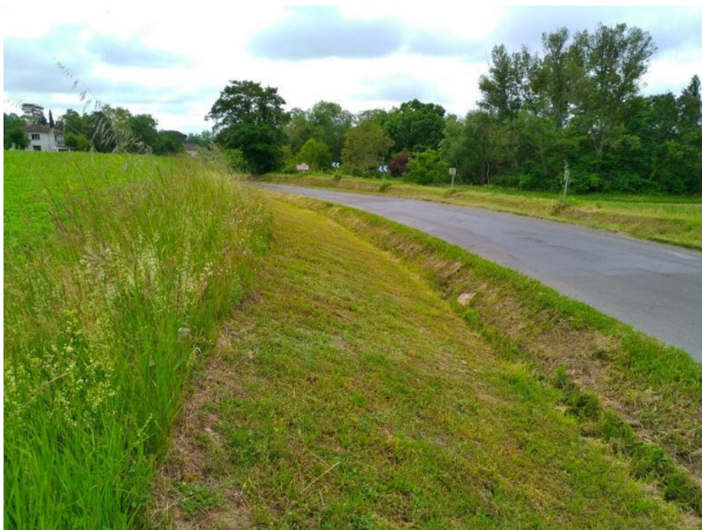
Figure 108 : Fossé © ETEN Environnement
