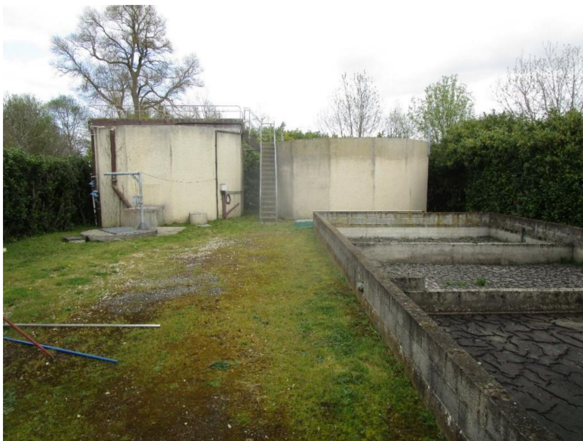
Figure 237 : Station d'épuration d'Auterive
