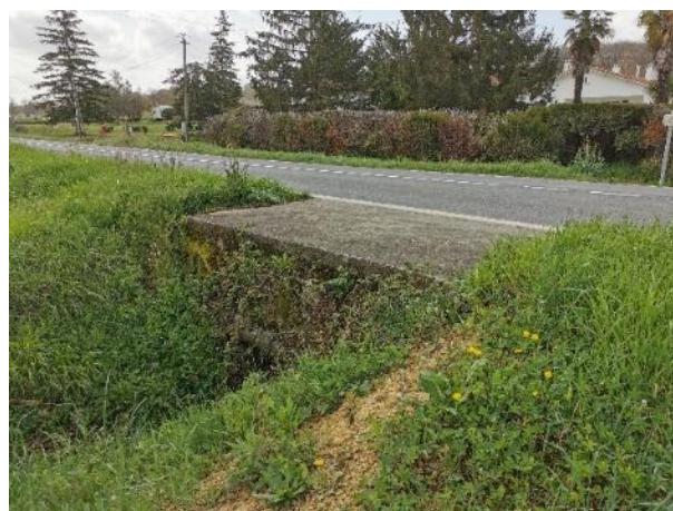
Photos 35 et 36 : Respectivement côté amont et côté aval du cours d'eau rejoignant le Gers traversé par la D 929. Côté amont, le chemin menant au circuit de motocross d'Auvergne est en pente, favorisant en partie les écoulements vers le fossé. Côté aval, présence d'une dalle béton favorisant le ruissellement.
