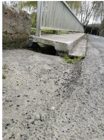
Photos 30 et 31 : Respectivement déversement d'une buse dans le Gers et partie inférieure du trottoir troué laissant s'écouler les eaux de ruissellement provenant du pont
