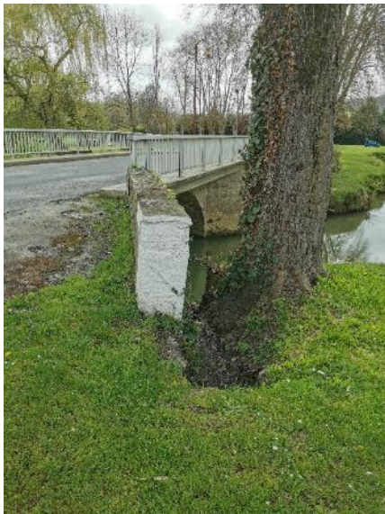
Photos 30 et 31 : Respectivement déversement d'une buse dans le Gers et partie inférieure du trottoir troué laissant s'écouler les eaux de ruissellement provenant du pont
