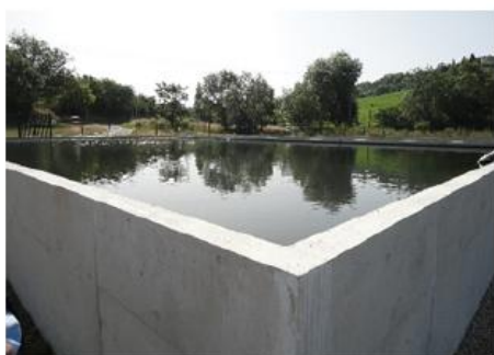
LIT EN REMPLISSAGE
