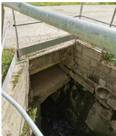
Photos 33 et 34 : petit pont traversant le Gers correspondant à un chemin d'accès agricole et ne présentant aucune protection face à de potentielles pollutions, excepté une barrière du côté aval.
