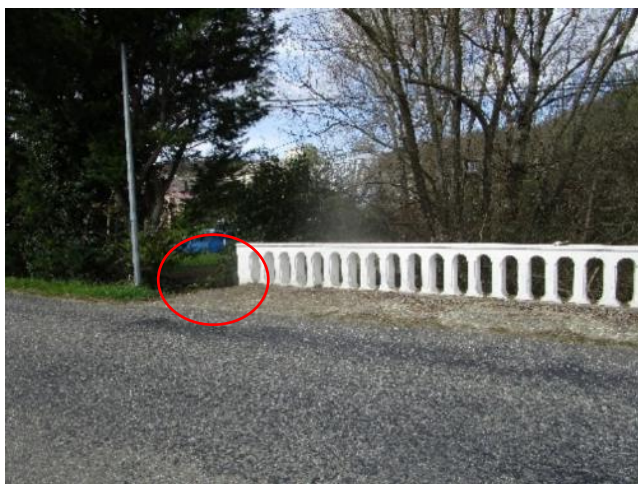
Photos 48 et 49 : Pont sur la RD 181 avec dalles béton favorisant le ruissellement dans le cours d'eau en dessous, et déversement direct dans le cours d'eau pour le côté amont (48). Du côté aval, présence d'une bande enherbée sur les abords pouvant limiter légèrement la pollution.
