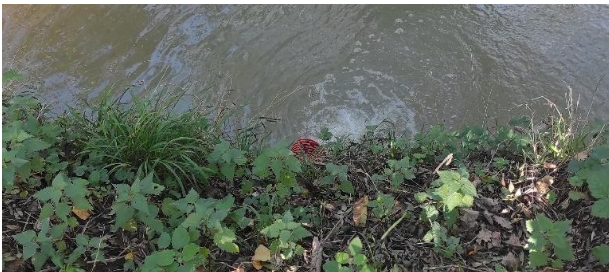
Figure 234 : Exutoire de drainage identifié lors de la visite du 06/11/2023
