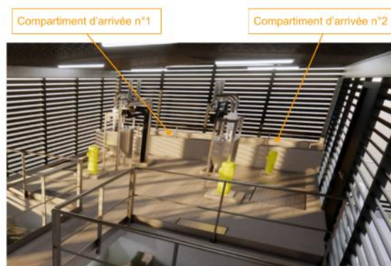
Figure 31 : Schéma de principe des compartiments de sécurité
