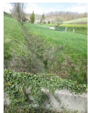
Photos 50 et 51 : Petite route traversant un cours d'eau, sans mesure de protection en aval (50) et avec un petit muret de protection en amont (51).
