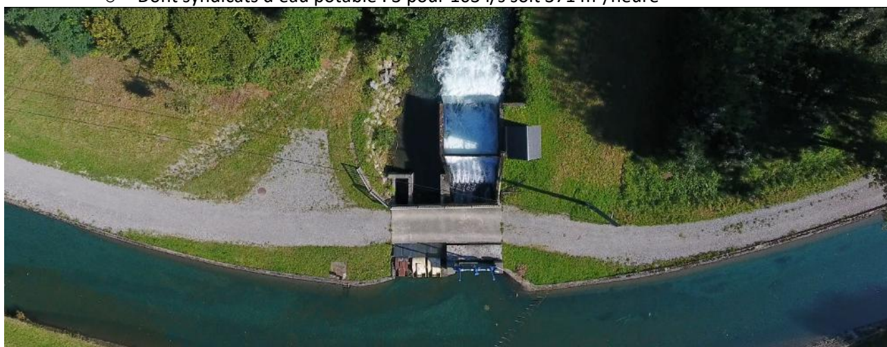
Figure 78 : Photographie aérienne du site de restitution dans le Gers – CACG
