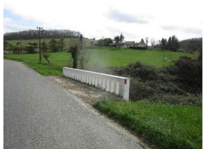
Photos 48 et 49 : Pont sur la RD 181 avec dalles béton favorisant le ruissellement dans le cours d'eau en dessous, et déversement direct dans le cours d'eau pour le côté amont (48). Du côté aval, présence d'une bande enherbée sur les abords pouvant limiter légèrement la pollution.
