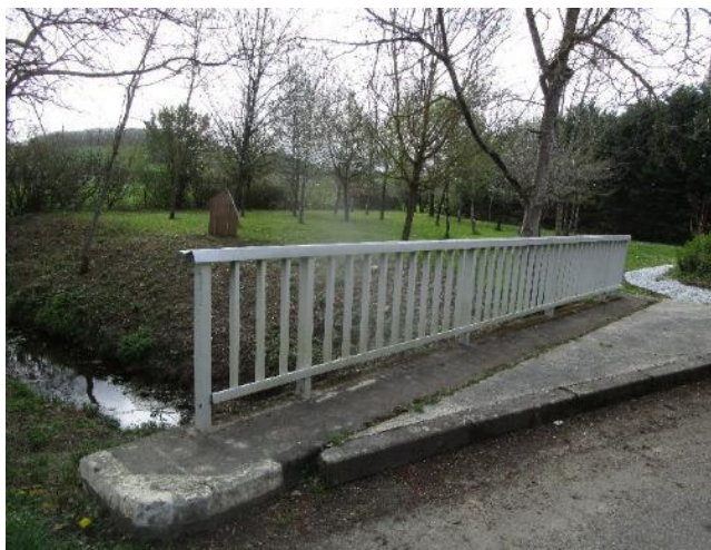
Photos 24 et 25 (à gauche) : Bordures du pont, avec petits trottoirs de protection mais écoulements possibles en amont et en aval de ceux-ci.
