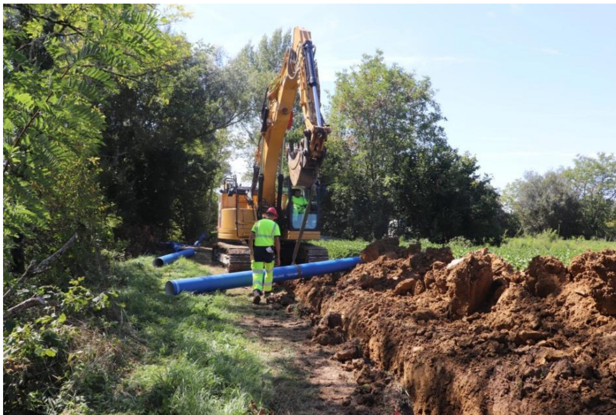
Figure 197 : Illustration de creusement d'une tranchée et de la mise en place d'une canalisations sur un projet similaire © ETEN environnement
