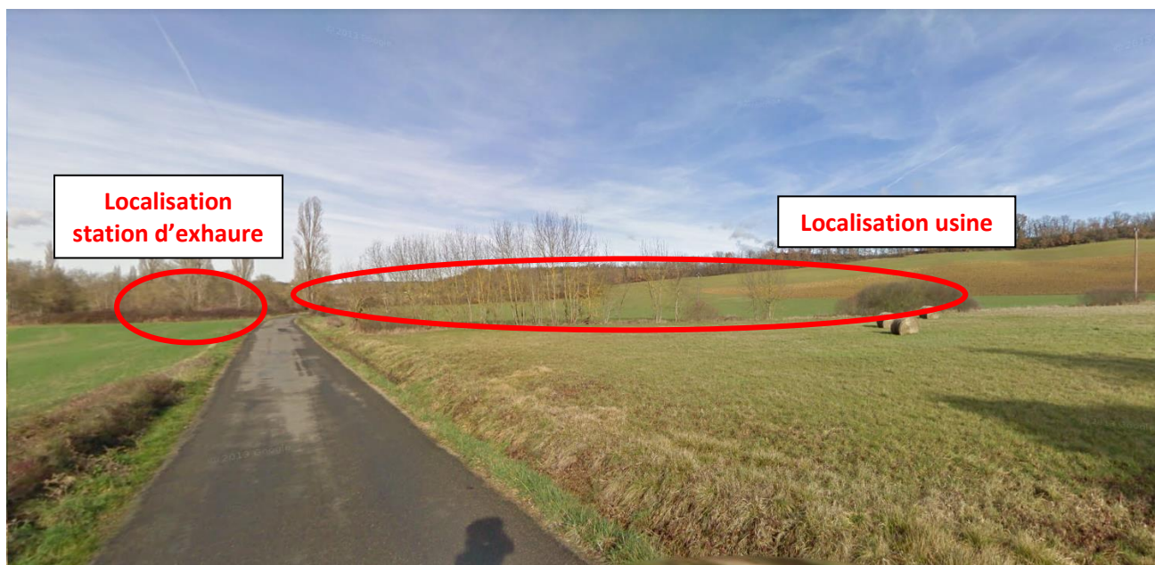
Figure 97 : Point de vue depuis la première maison située au Sud de l'usine ©ETEN environnement
