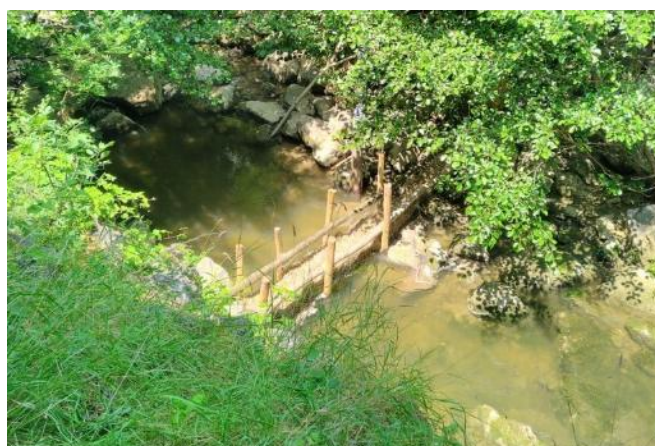
Figure 201 : Filtre à paille mis en place dans le cadre de travaux sur les berges du Tescou © ETEN environnement
