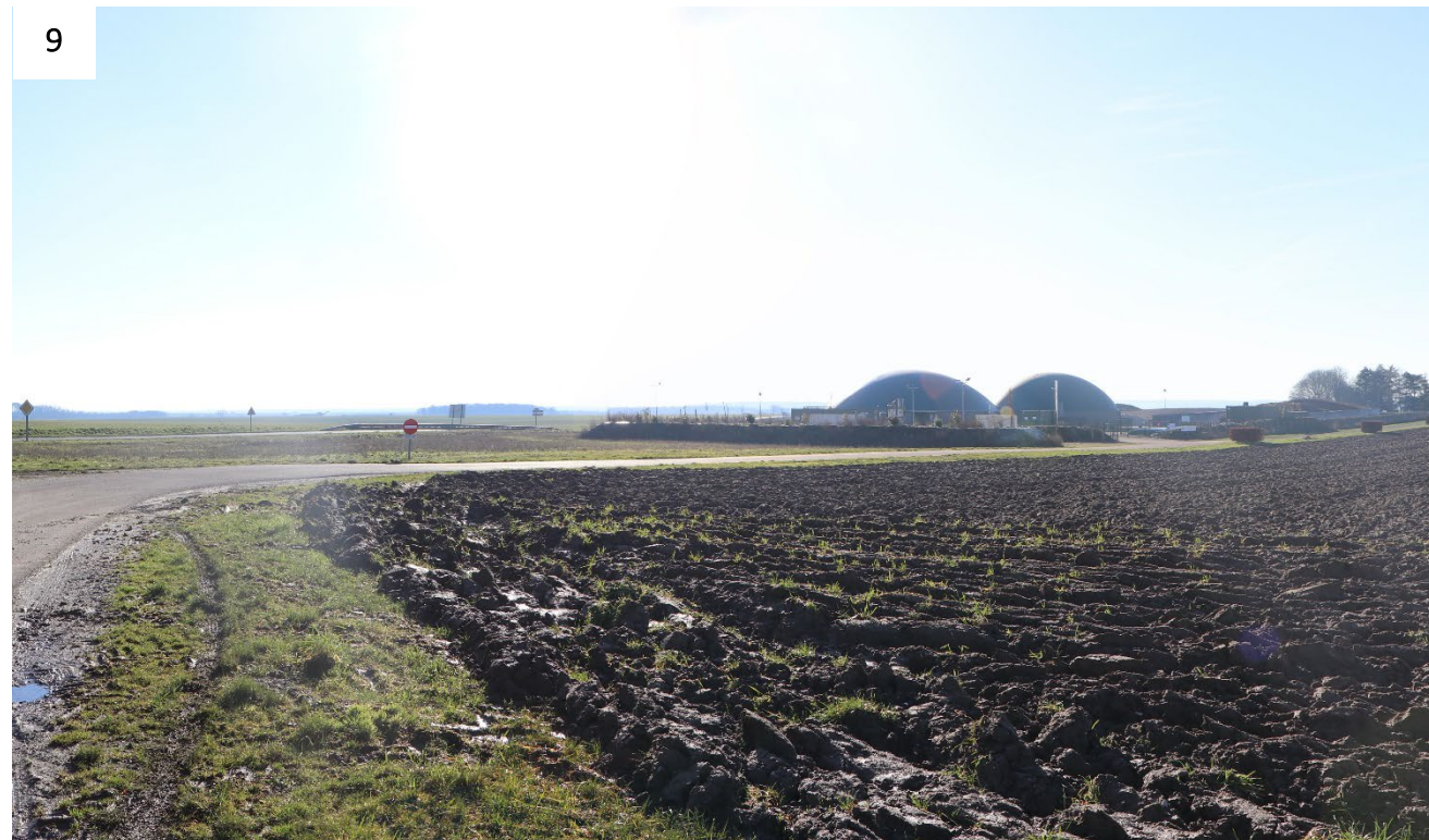
Figure 12 : Vue du méthaniseur de Plainval depuis la D23 (©ATER Environnement, 2025)
