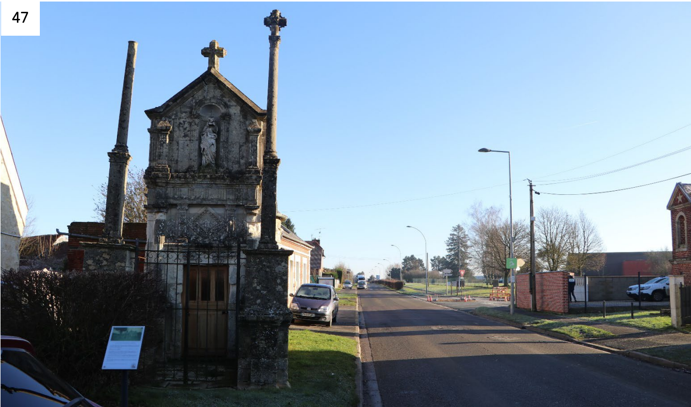
Figure 50 : Chapelle classée de Maignelay-Montigny (@ATER Environnement, 2025)
