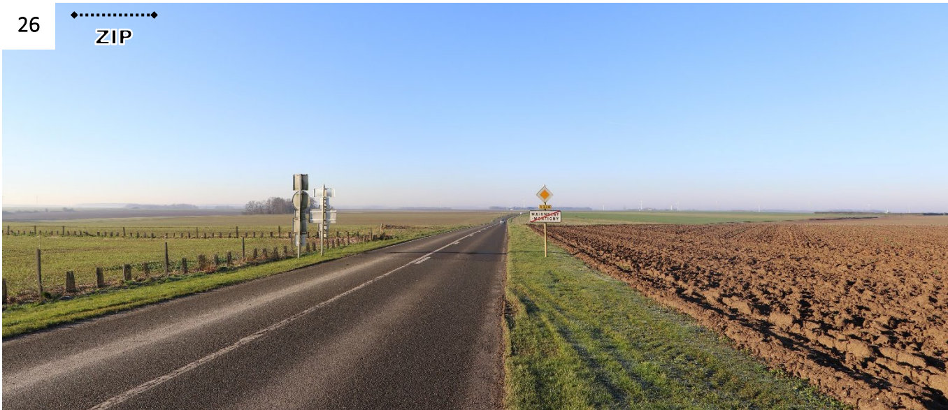
Figure 29 : Vue de la sortie ouest de Maignelay-Montigny depuis la D938 (@ATER Environnement, 2025)
