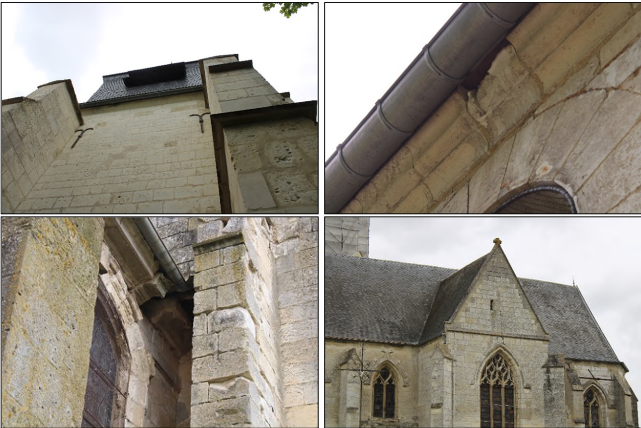
Photographie 16 : Exemples de gîtes bâtis potentiels observés au sein de l'aire d'étude dans des églises
