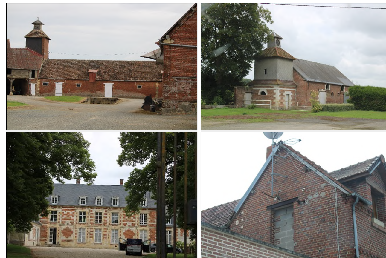
Photographie 15 : Exemples de gîtes bâtis potentiels observés au sein de l'aire d'étude
