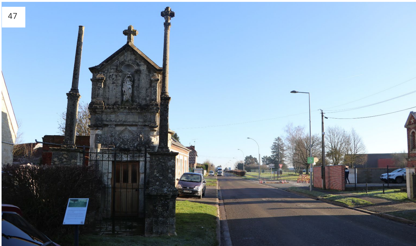
Figure 64 : Chapelle classée de Maignelay-Montigny (©ATER Environnement, 2025)
