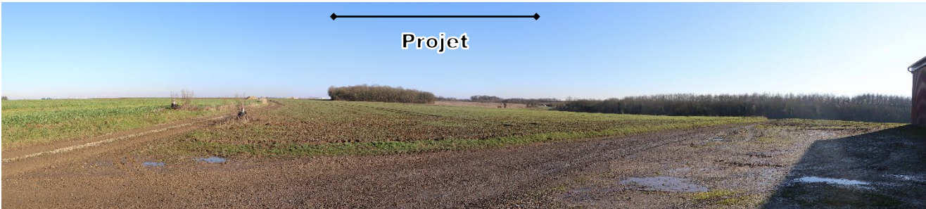
Figure 103 : Vue depuis la sortie est de Lèvermont (©ATER Environnement, 2025)
