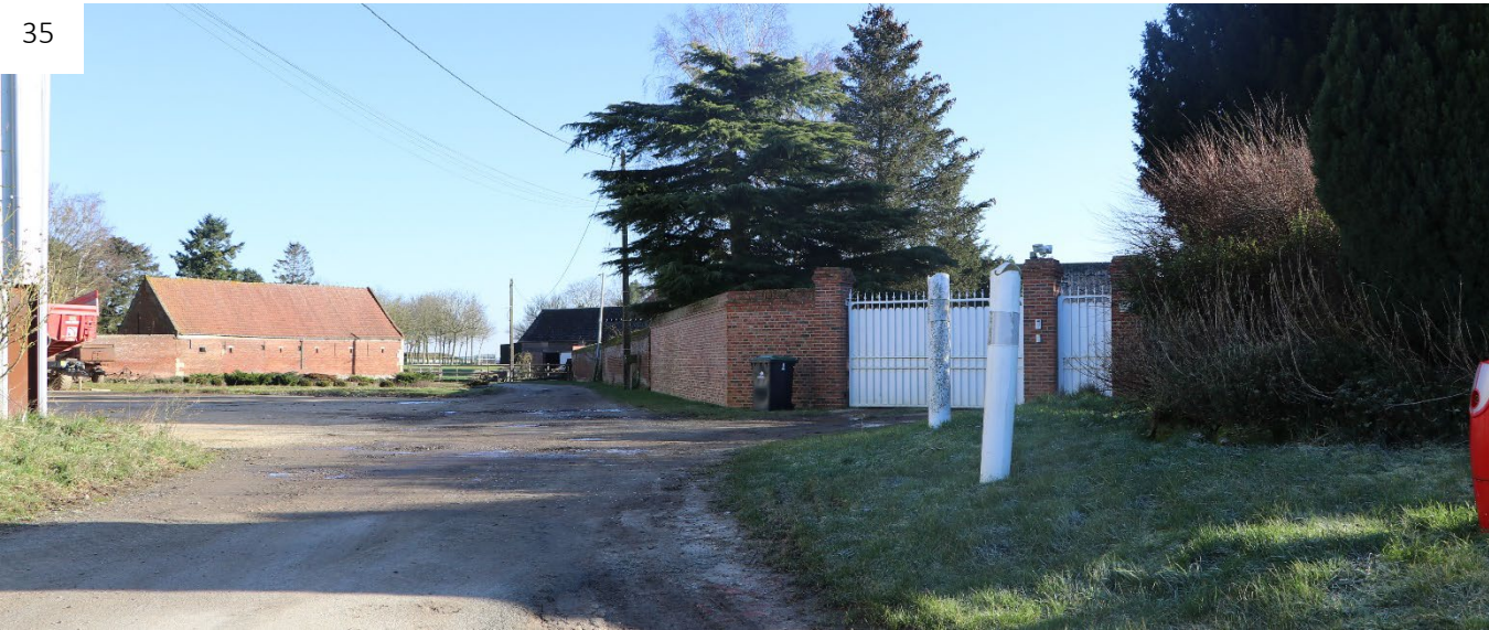
Figure 52 : Vue de la ferme de la Fosse Thibault (©ATER Environnement, 2025)
