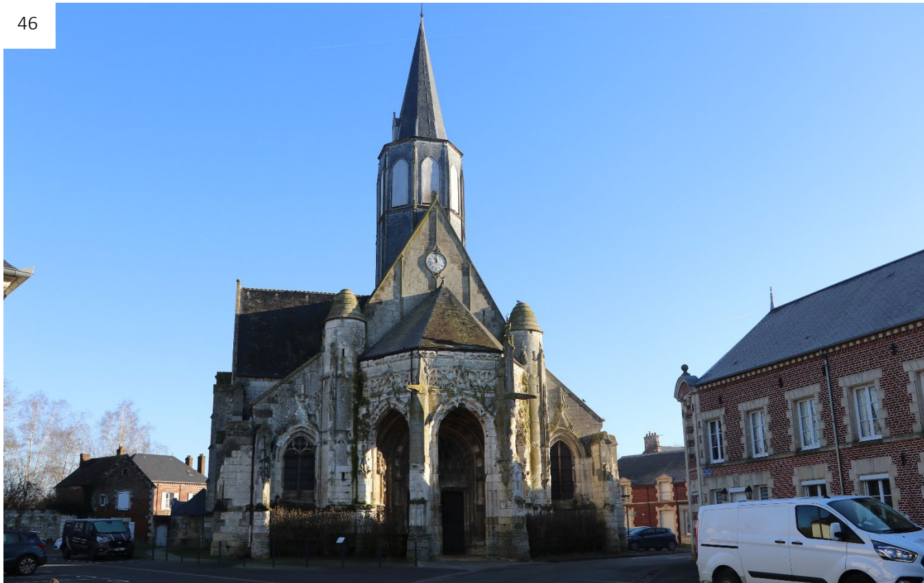
Figure 63 : Eglise classée Sainte Marie-Madeleine de Maignelay (©ATER Environnement, 2025)
