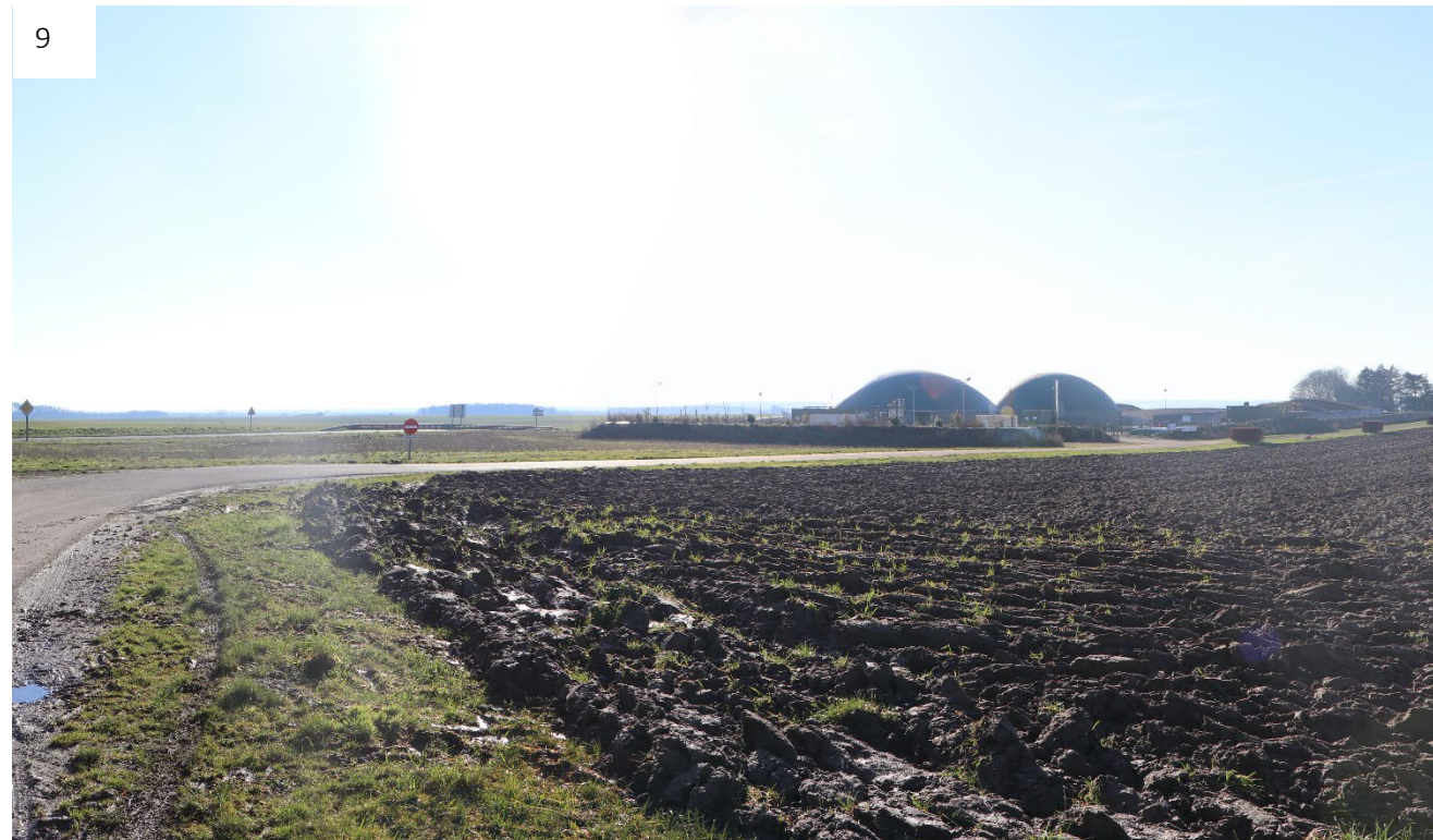
Figure 26 : Vue du méthaniseur de Plainval depuis la D23 (©ATER Environnement, 2025)
