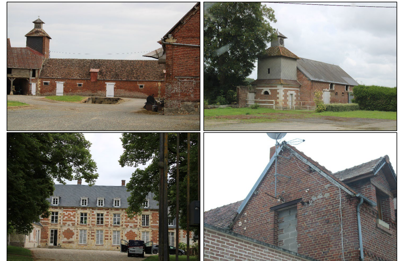
Figure 89 : Exemples de gîtes bâtis potentiels observés au sein de l'aire d'étude
