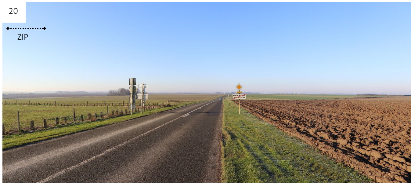
Figure 37 : Vue de la sortie ouest de Maignelay-Montigny depuis la D938 (©ATER Environnement, 2025)
