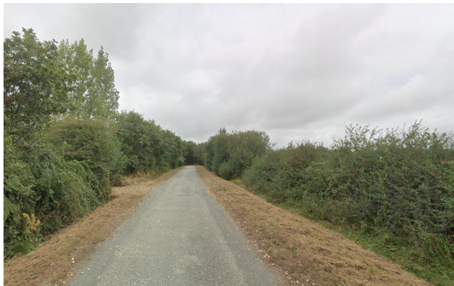
Figure 8 : Vue de la voie existante (Source : Google StreetView, août 2024)
