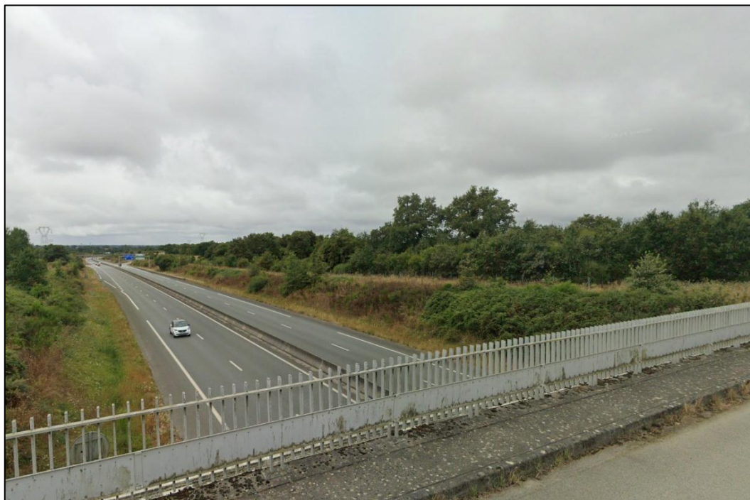
Figure 17 : Vue éloignée du site depuis le pont du chemin des Garennes au-dessus de l'autoroute (Source : Google StreetView, août 2024)
