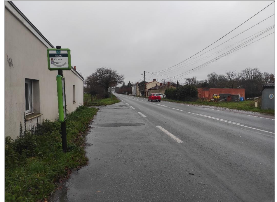
Arrêt "Valmy" le long de la RD746
