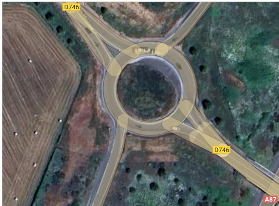
Giratoire C2 RD746 / accès Ouest A87 (Source : Google Maps)
