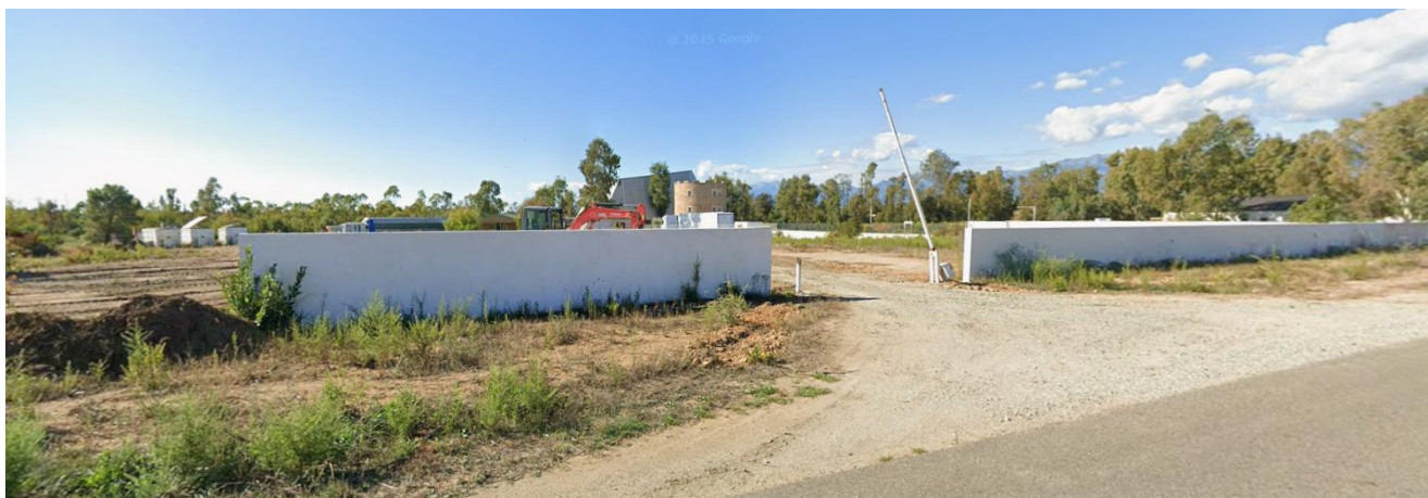
Photo 2 – Entrée (publique) du futur crématorium
