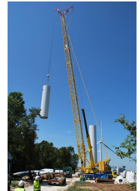
Montage du mât de l'éolienne (Mons du Lomont)
