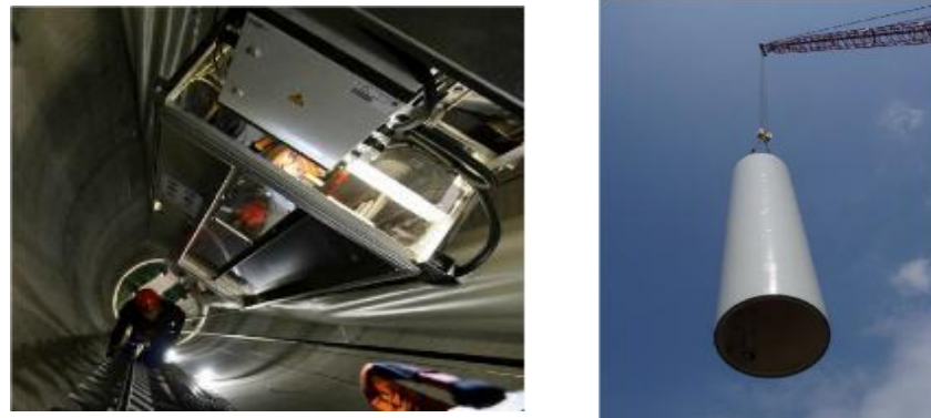
Le mât (intérieur et tronçon de mât en phase d'installation)
