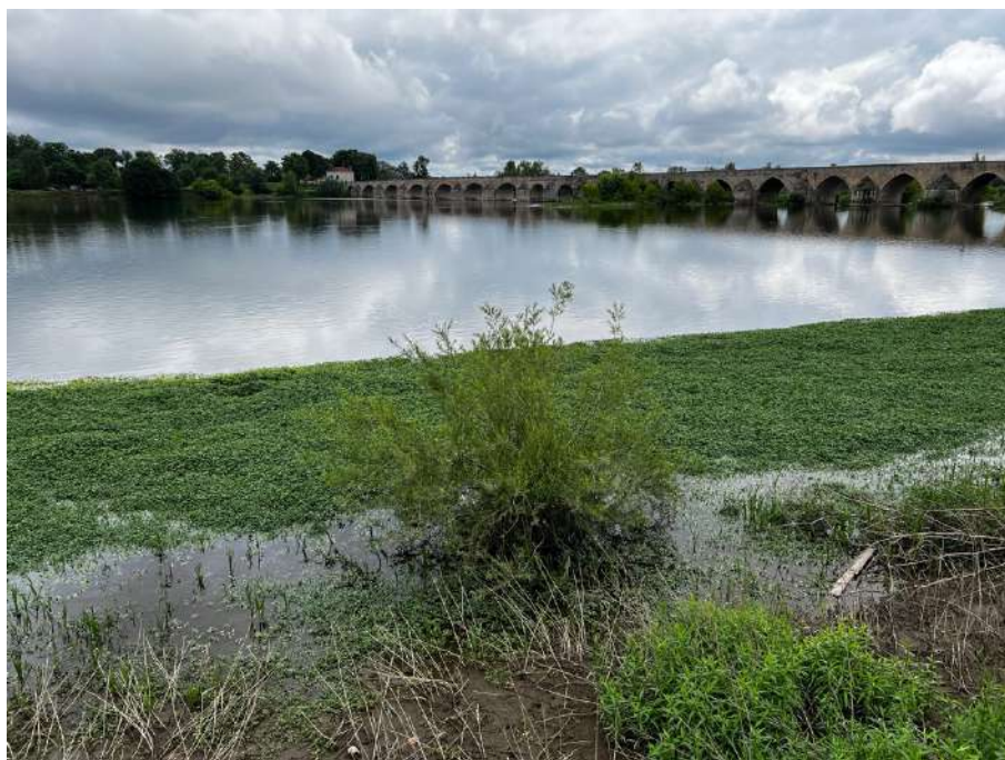
Photo N°23 - Bord de Loire - Pont de Beaugency
