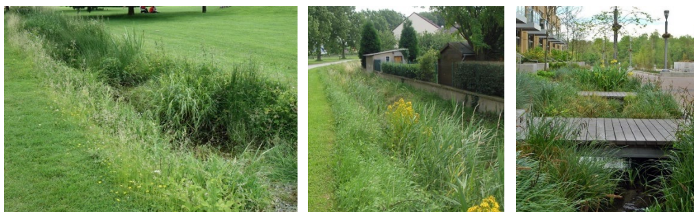
Réseau hydraulique à ciel ouvert
