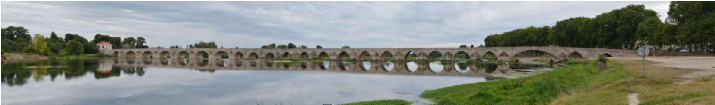
Le pont de Beaugency - Pont reposant sur des arches de différentes factures
