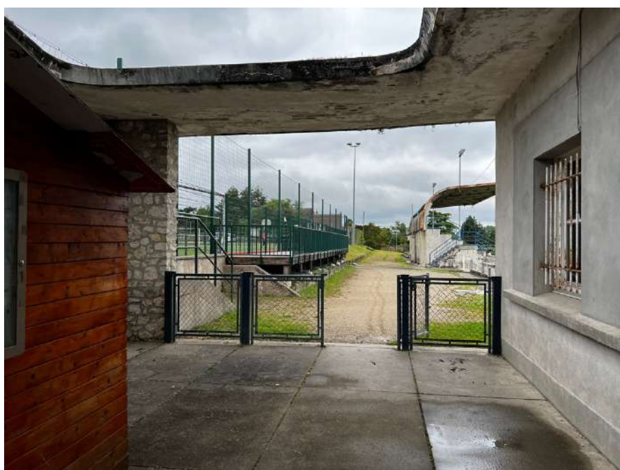
Photo N°8 - Entrée du stade - Vue intérieure
