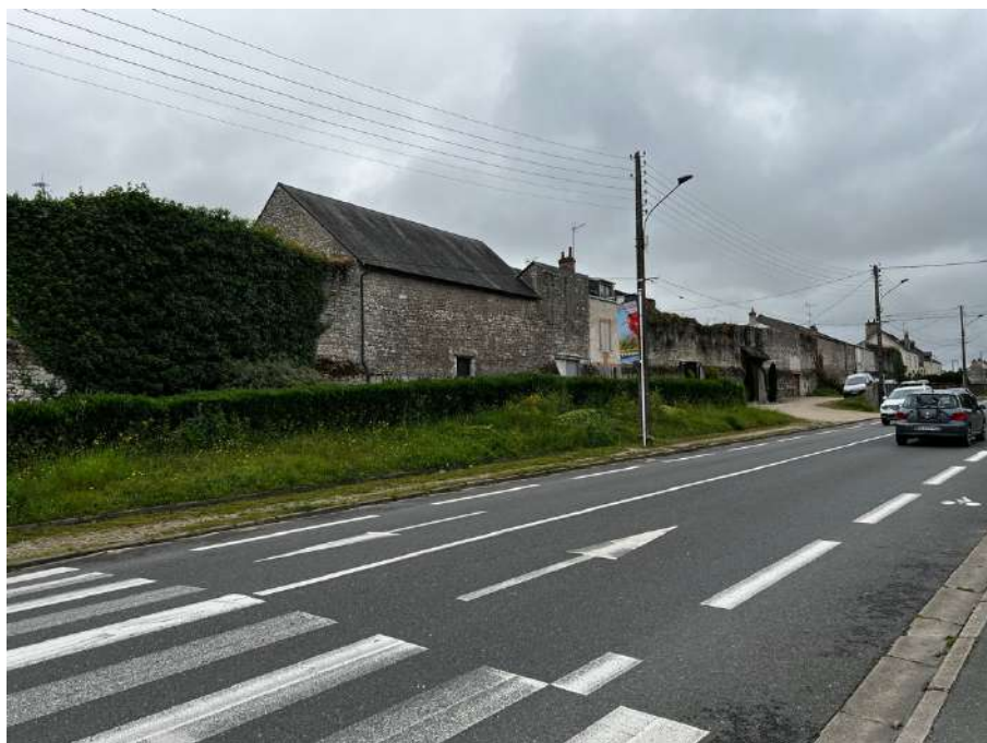
Photo N°5 - Avenue de Chambord - Vis-à-vis
