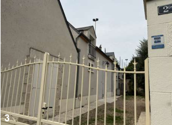
Aperçus des projecteurs du stade depuis la rue des Iles
