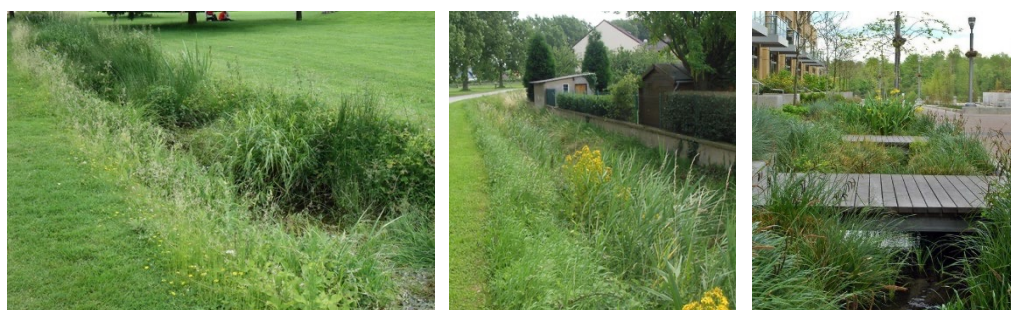
Réseau hydraulique à ciel ouvert
