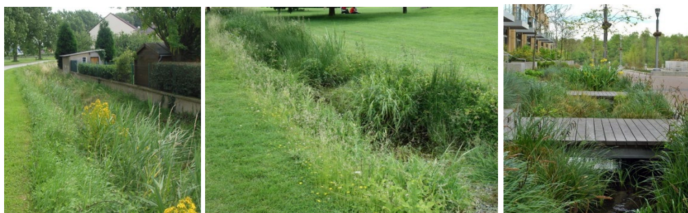
Réseau hydraulique à ciel ouvert
