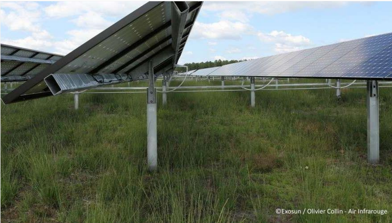
Exemple de suiveur mono-axial (Source : Exosun)
