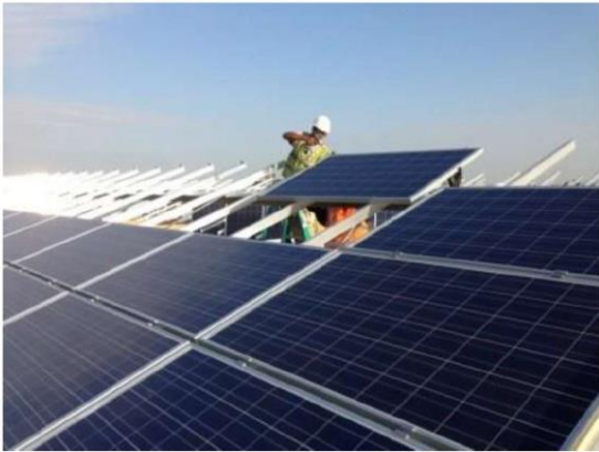
Mise en place d’un module sur une table d’assemblage (Source : Auddicé environnement)
