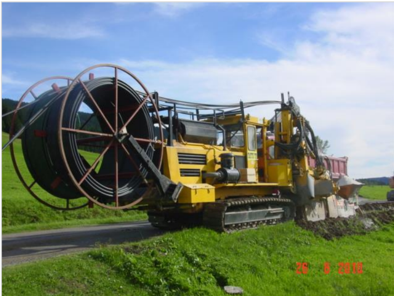
Pose de câbles le long d’une route départementale (Source : TATTU T.P.)
