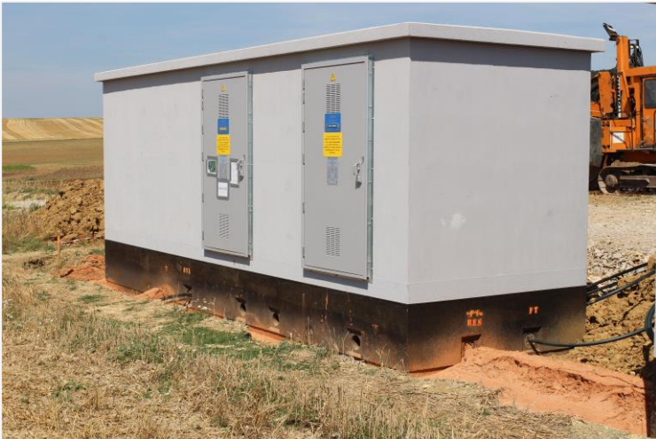
Installation d’un poste livraison (Source : Ora environnement)
