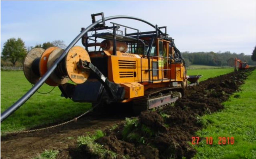
Photo 42 : Type de trancheuse utilisée dans le cadre d'enfouissement de câbles (Source : tatttu.fr)
