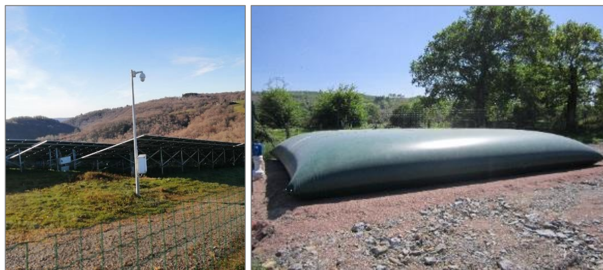
Photographie 7 : Caméra de vidéosurveillance (à gauche) et citerne incendie (à droite) (Source : ENCIS Environnement)
