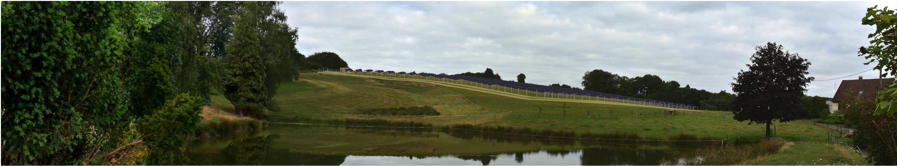
PROJET Vue après travaux
