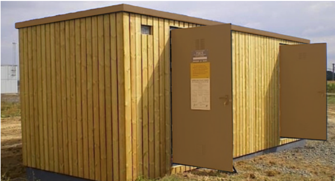
EXEMPLE D'UN POSTE DE LIVRAISON
