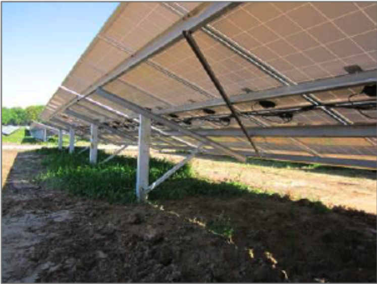
PHOTO STRUCTURE PORTEUSE DE LA TABLE
