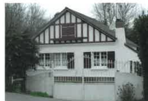
Exemple de façade à colombages apparents
