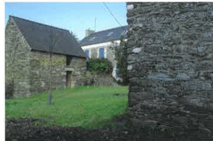
Exemple de murs en pierres avec des joints beurrés, reliant les pierres entre elles plutôt que de les souligner une à une.
