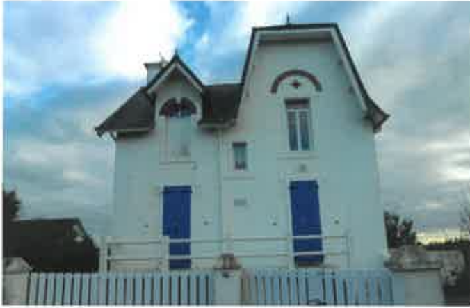
Les toitures à pans multiples de l'architecture balnéaire se prêtent rarement à l'implantation de panneaux
