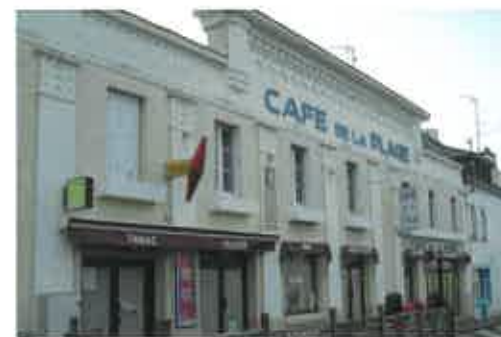
Exemple de façade Art Déco
