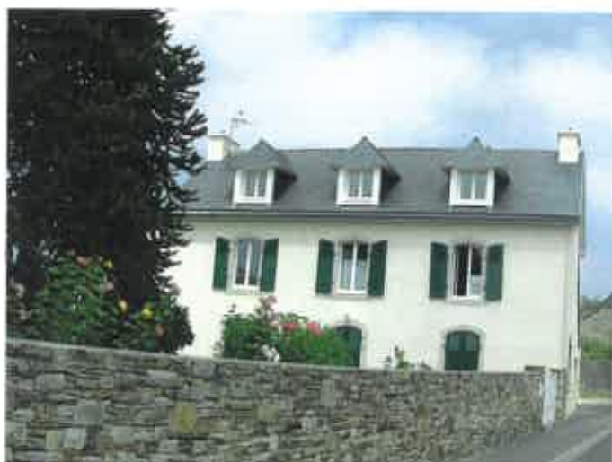
exemple de façade enduite à la chaux
