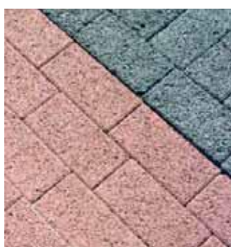
Pavé en dalles de béton : Matériau imperméable ou perméable. Possibilité de rendre la surface revêtue perméable par l'utilisation de joints perméables
