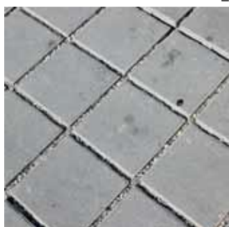
Pavé en béton poreux
