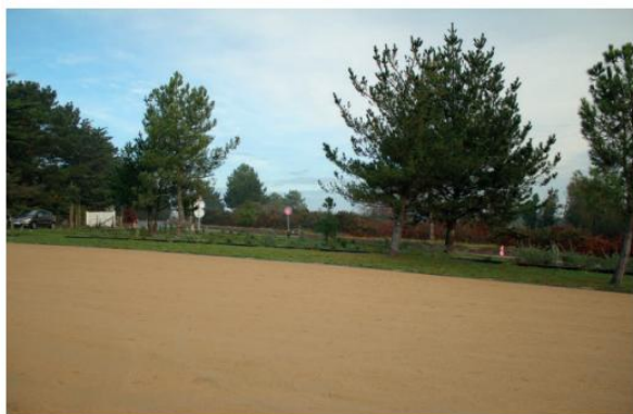
Exemple d'espaces de stationnement poreux / perméables ; Source : Cahier de recommandations architecturales et paysagères Extension de la zone d'activités économiques de KERVIDANOU 1 à Quimperlé ; Horizons Paysage et aménagements / 2LM / DMEAU
