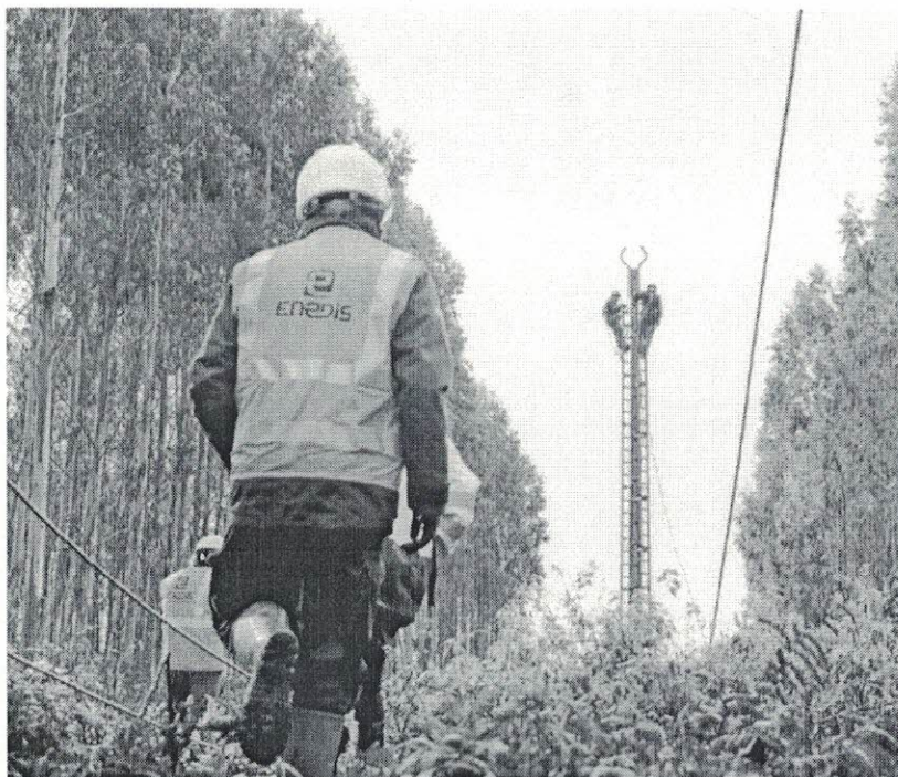
Le personnel d'Enedis multiplie les interventions, partout en Bretagne, pour consolider le réseau électrique après le passage de la tempête Ciaran. Photo Lionel Le Saux
