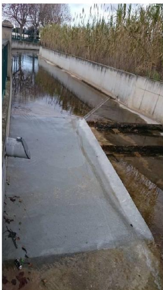
Figure 24 : double seuil du Roubaud après réalisation des travaux compensatoires (Rapport annuel d'exploitation novembre 2024-avril 2025 – SONDALP)
