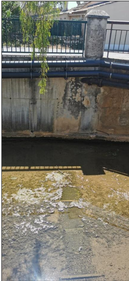
Figure 12 : prise d'eau d'Aquarenova
