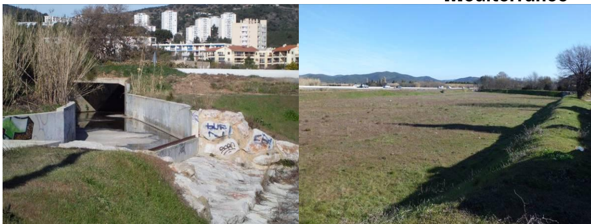
Figure 102 : Déversoir de la Ritorte dans le bassin de rétention et vue du bassin avant mise en place d'Aquarenova 1 (SUEZ Consulting, 2012)
