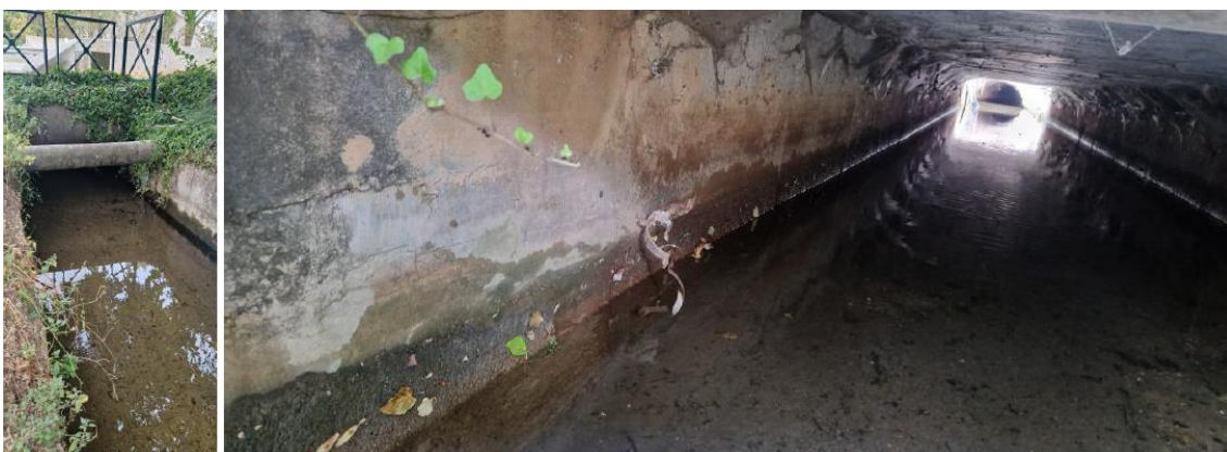
Figure 161 : Instrumentation du point 2 (SONDALP, 2025)
