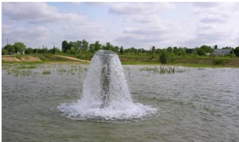
Figure 61 : Exemple d'arrivée d'eau en tulipe (Source : APD, Suez Eau France)
