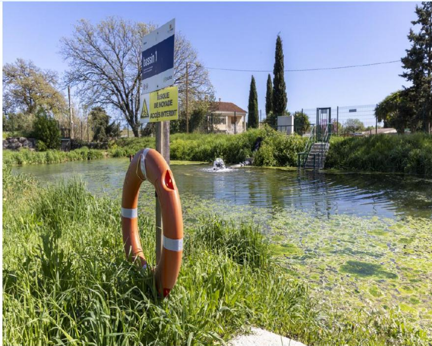
Figure 6 : Exemple d'escalier d'accès au bassin (Source : APD, Suez Eau France)
