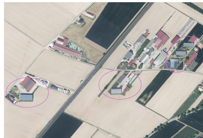
Photo n° 2 : Photovoltaïque sur toiture d'exploitations agricoles à l'ouest d'Ebersheim (vue aérienne de 2021)
