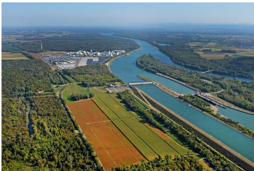
Photo n° 1 : Centrale hydroélectrique et écluse sur le Rhin - Marckolsheim
