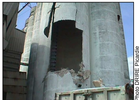
Rupture cellule à Vailly sur Aisne. (02)
