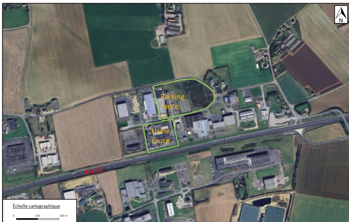
Figure 4 : Vue aérienne du site FAURE
