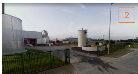
Portail entrée de site. Motorisé, fermé. Accès arrivée de gaz, sprinklage
