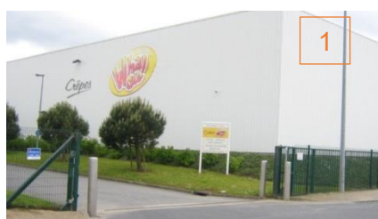
Portail de sortie. Motorisé, fermé.
