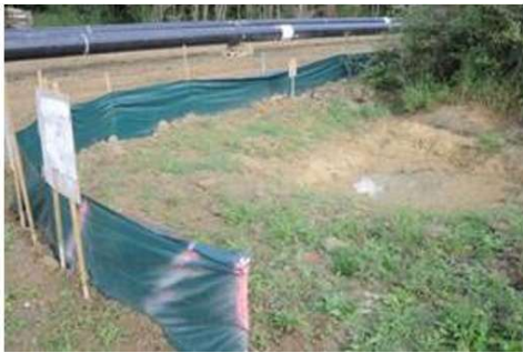
Exemple de bâche anti-intrusion (photo : C. Juhe)
