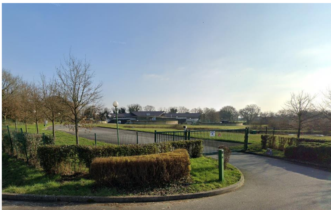
Figure 3 : Vue de la station d'épuration
