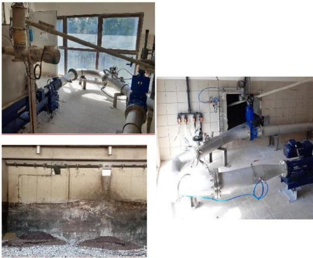
Figure 28 : Centrifugeuse et chaulage
