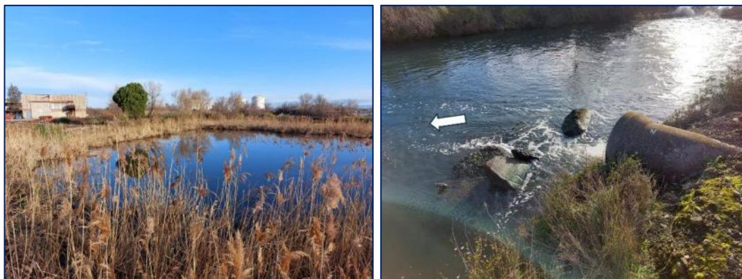
Figure 12 : Bassin à l'exutoire (photo de gauche) et sortie en station de pompage (photo de droite)
