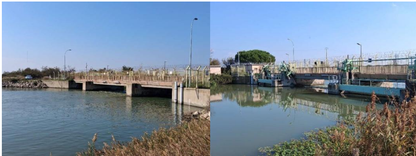
Figure III-30 : Barrage anti-sel – Vue depuis l’aval (à gauche) et depuis l’amont (à droite) (octobre 2025)
