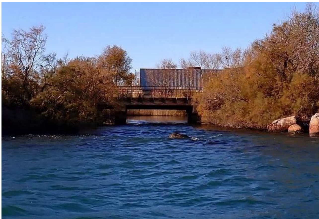
Figure 2 : Débouché du canal recevant les rejets en darse 1
