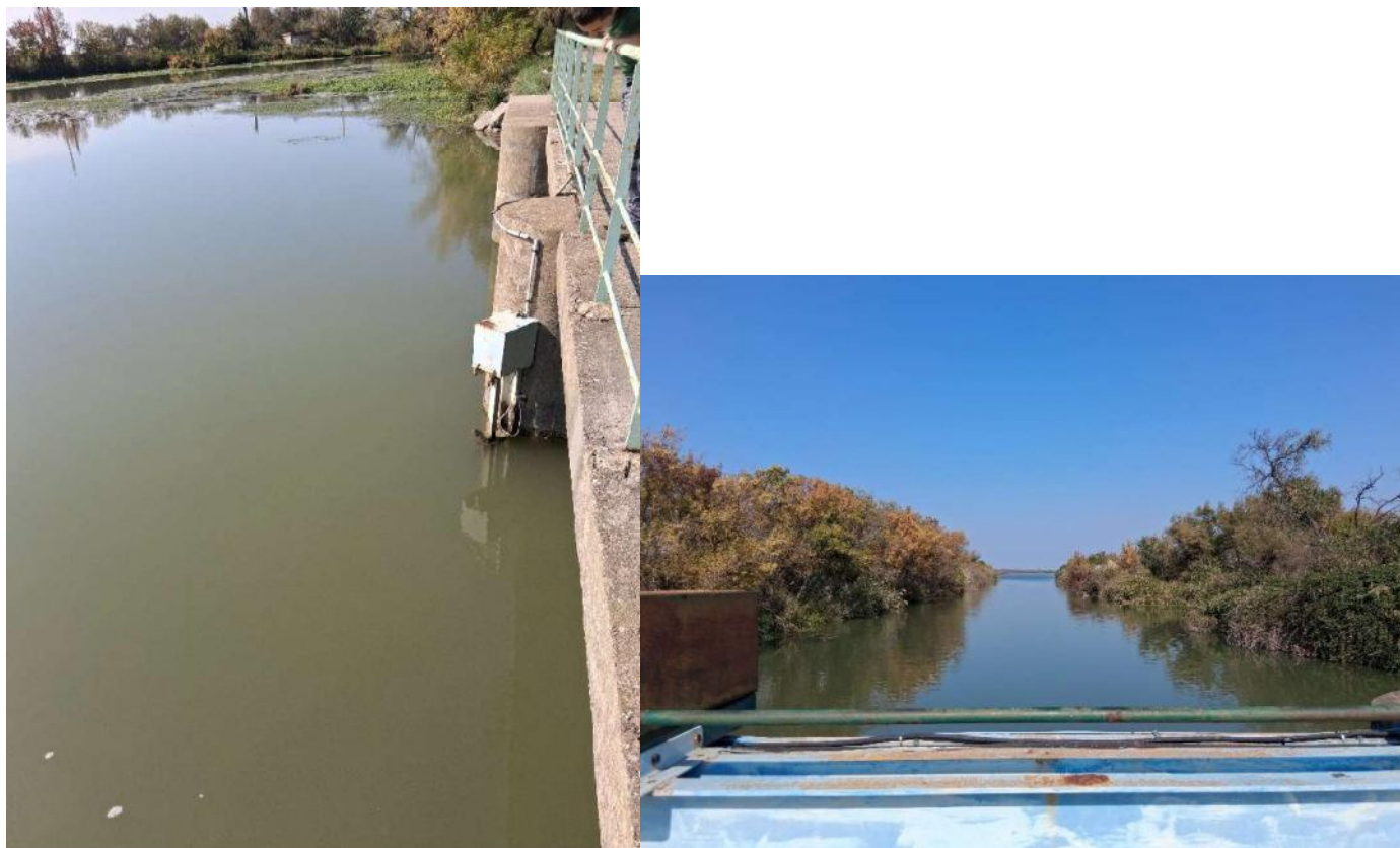
Figure III-31 : Ouvrage du Galéjon – Vue depuis l’aval et vue vers l’amont (octobre 2025)
