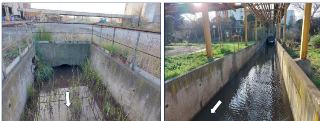
Figure 10 : Roubine en amont du bassin de l'aciérie (photo de gauche) et en aval de l'aciérie (photo de droite)
