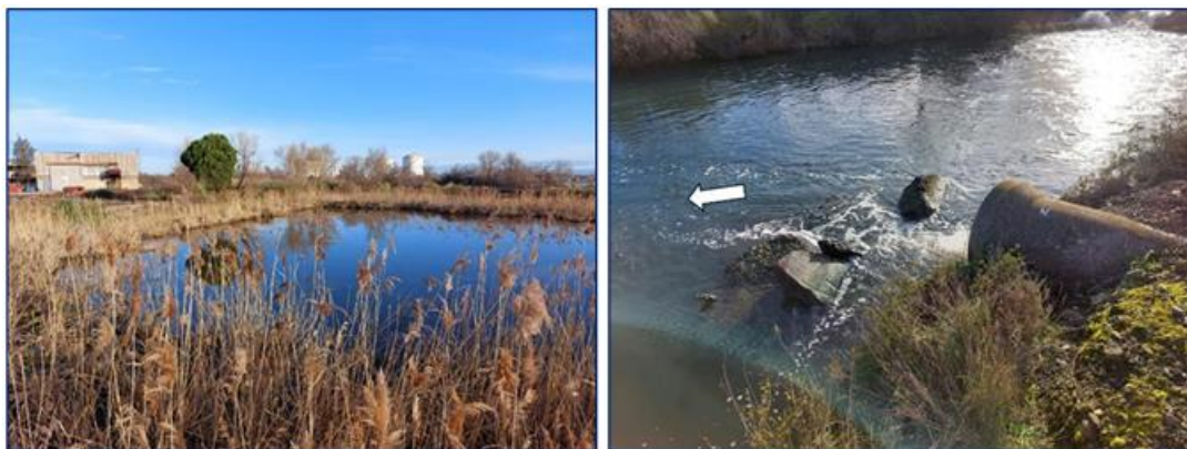
Figure 291: Bassin à l'exutoire (photo de gauche) et sortie en station de pompage (photo de droite)
