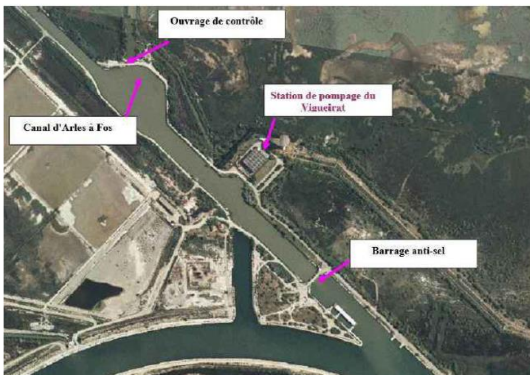
Figure 80: Station et ouvrages de Vigueirat
