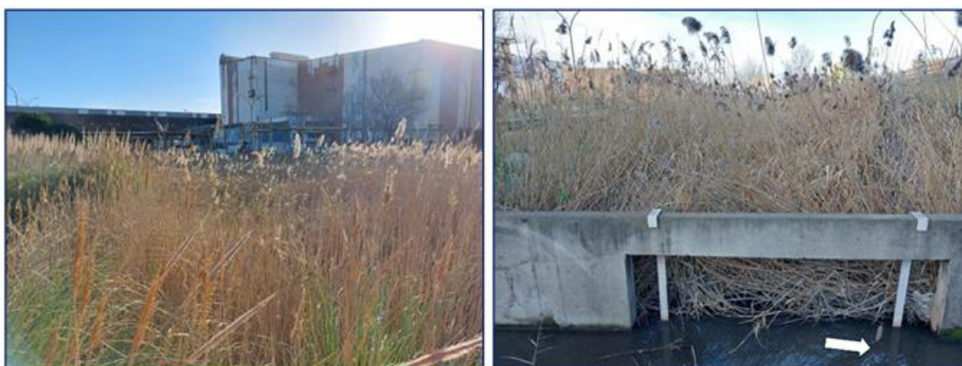
Figure 292: Bassin de rétention au niveau de l'aciérie (photo de gauche) et liaison aval avec la roubine de l'aciérie (photo de droite)
