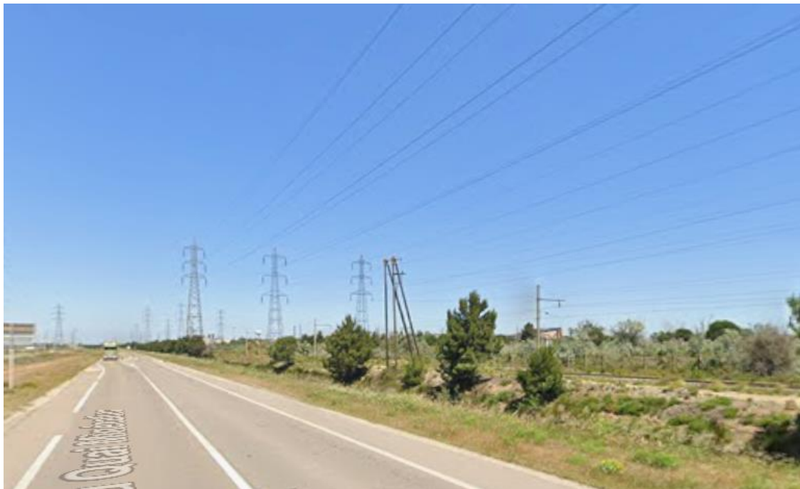
Figure 274 : Point de vue n°3 – Vue depuis la route du quai Minéralier au sud de MARCEGAGLIA (Source : Google street view - 2026)
