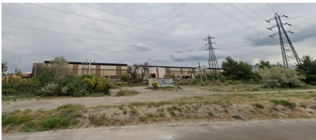
Figure 173 : Vue du site depuis la route du quai minéralier (photo n°2)
