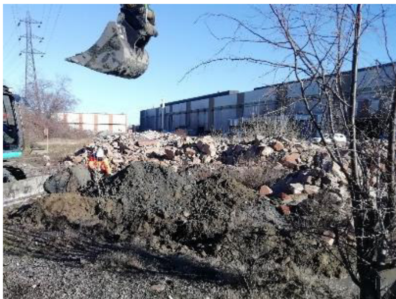
Illustration 21 : Photographie du merlon de matériaux de démolition et de déchets divers dans le secteur du sondage E44
