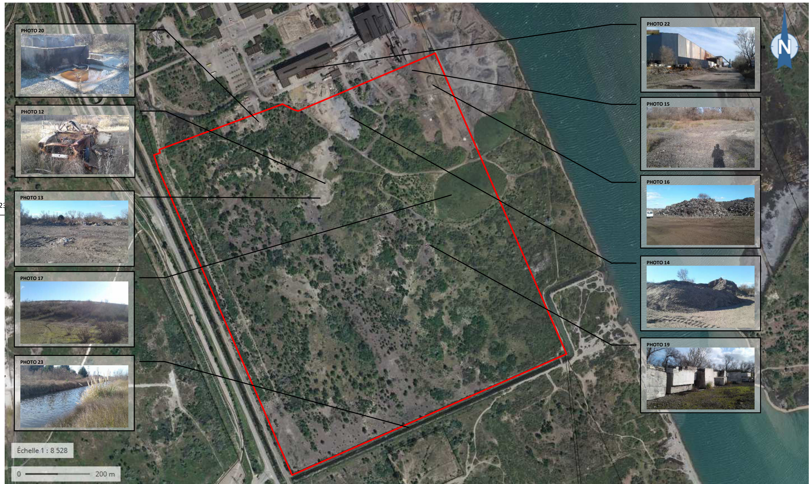
Figure 8 : Photographies des constats relevés – Zone Sud
