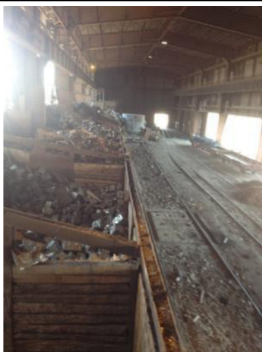
Photographie 1 : Hall à ferrailles
