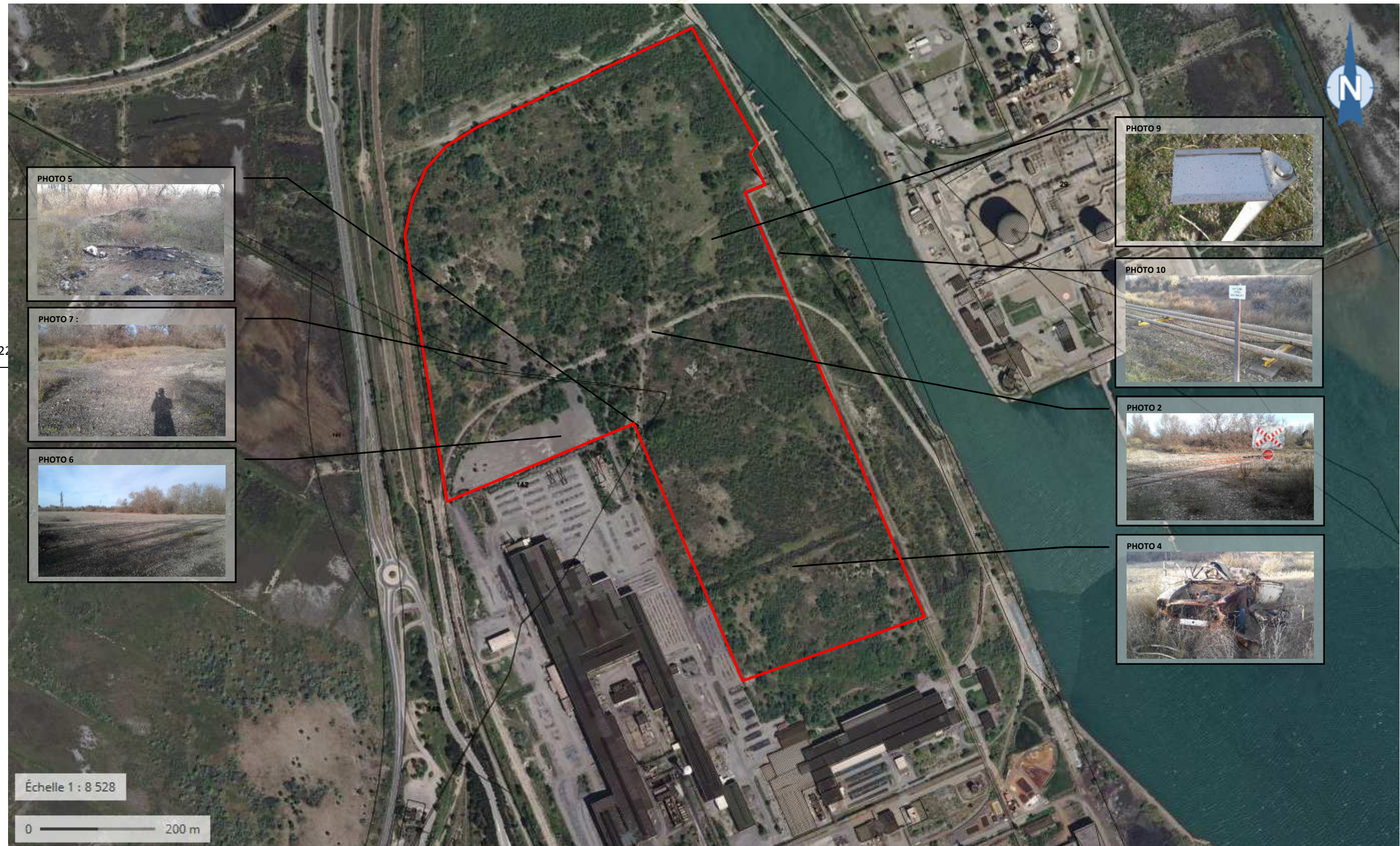
Figure 7 : Photographies des constats relevés – Zone Nord
